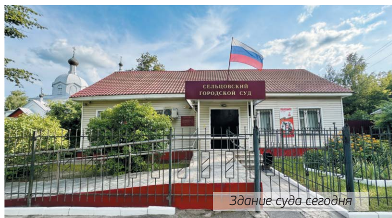
Здание суда по ул. Лягина до ремонта
